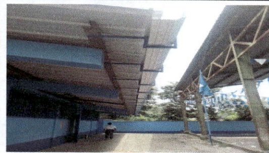
FOTO 2: SUSTITUCION DE CANAL DE METAL
