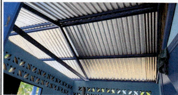
FOTO 4: SUSTITUCION DE SOPORTE DE MADERA POR METAL.
