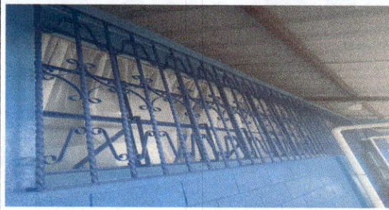
FOTO 1: MANTENIMIENTO A BALCONES DE METAL
